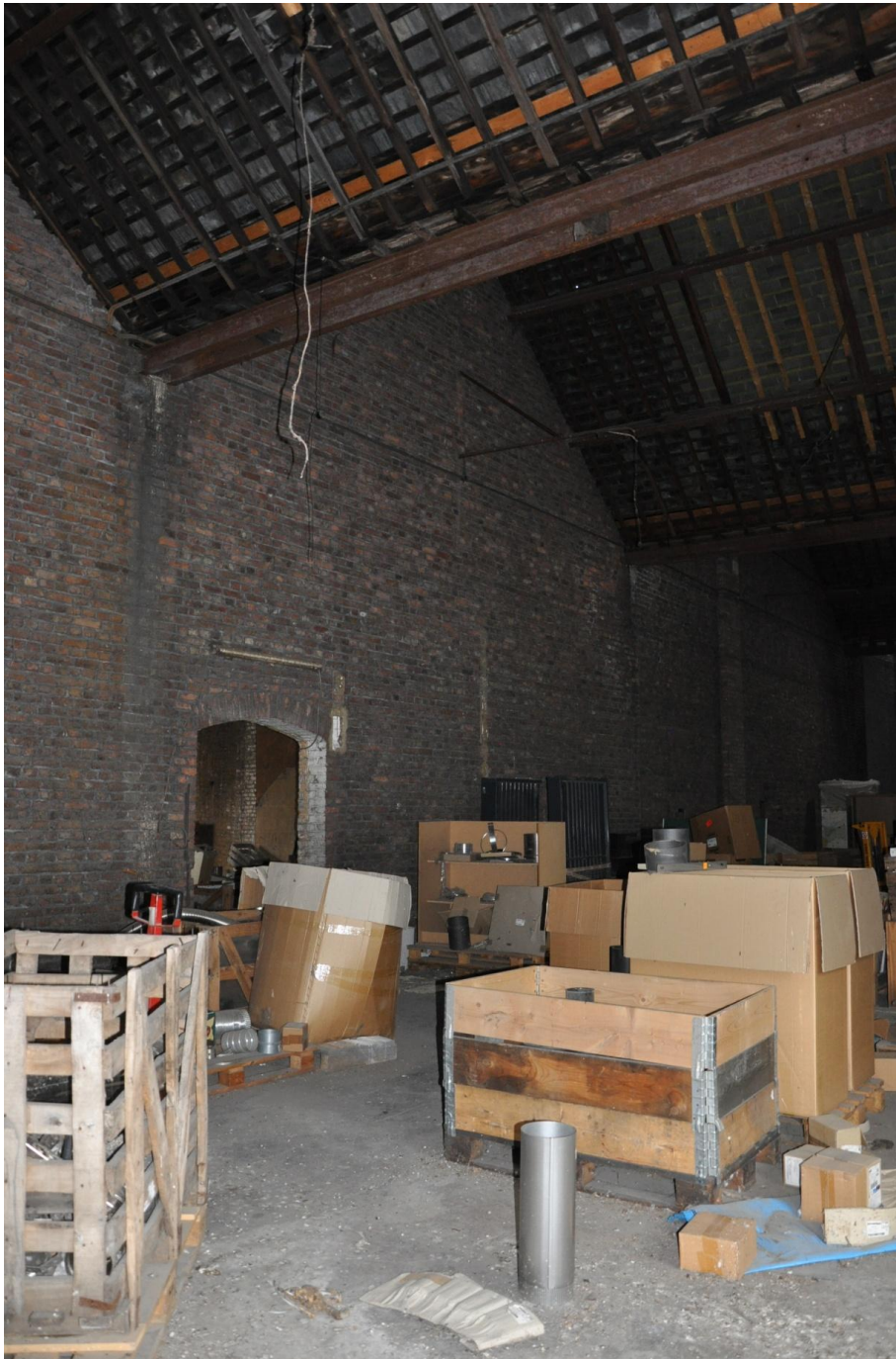
Mur de refend courant devant les quatre halls et toitures en bâtière épousant les quatre pignons à rue.
