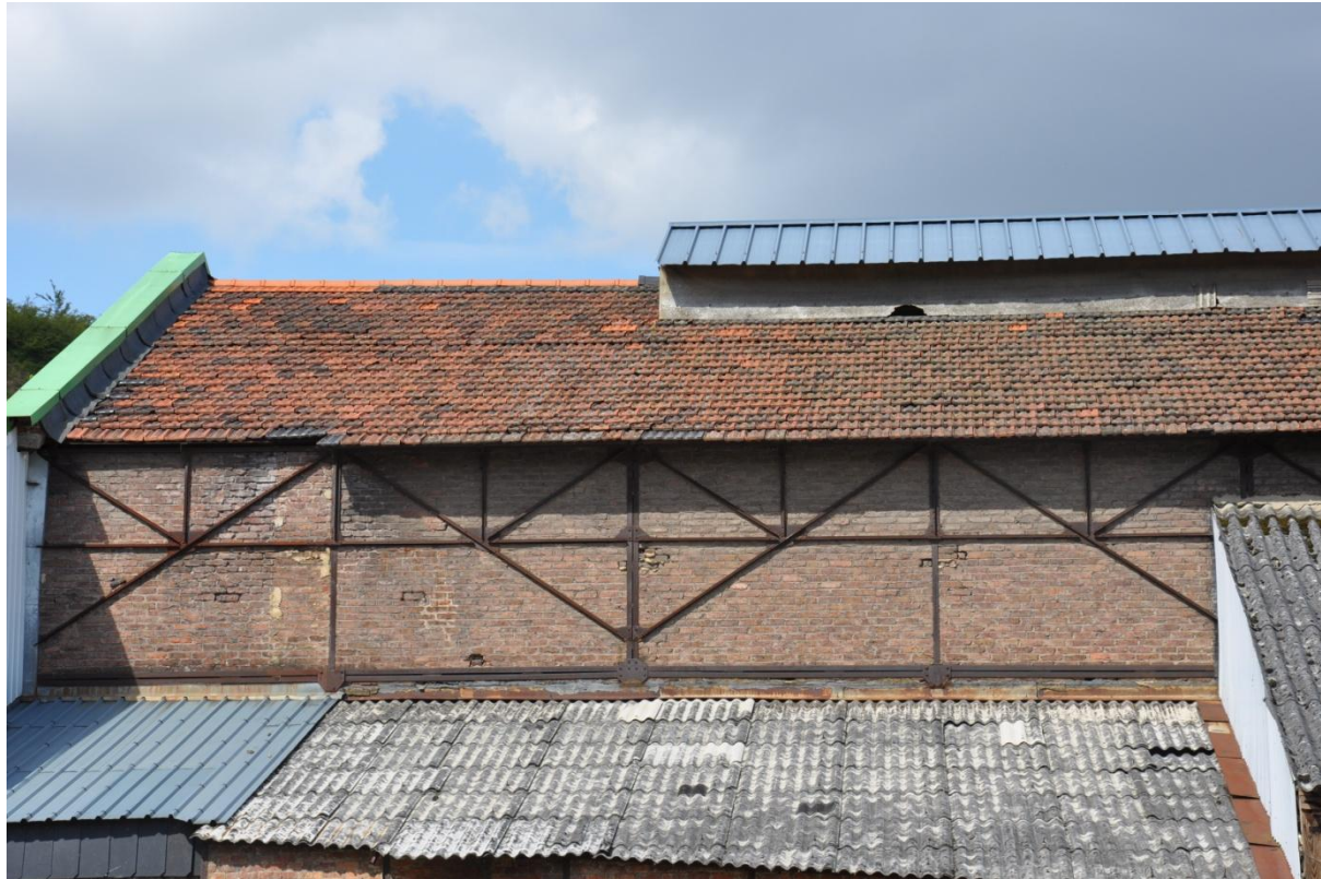
Structure métallique du hall 1
