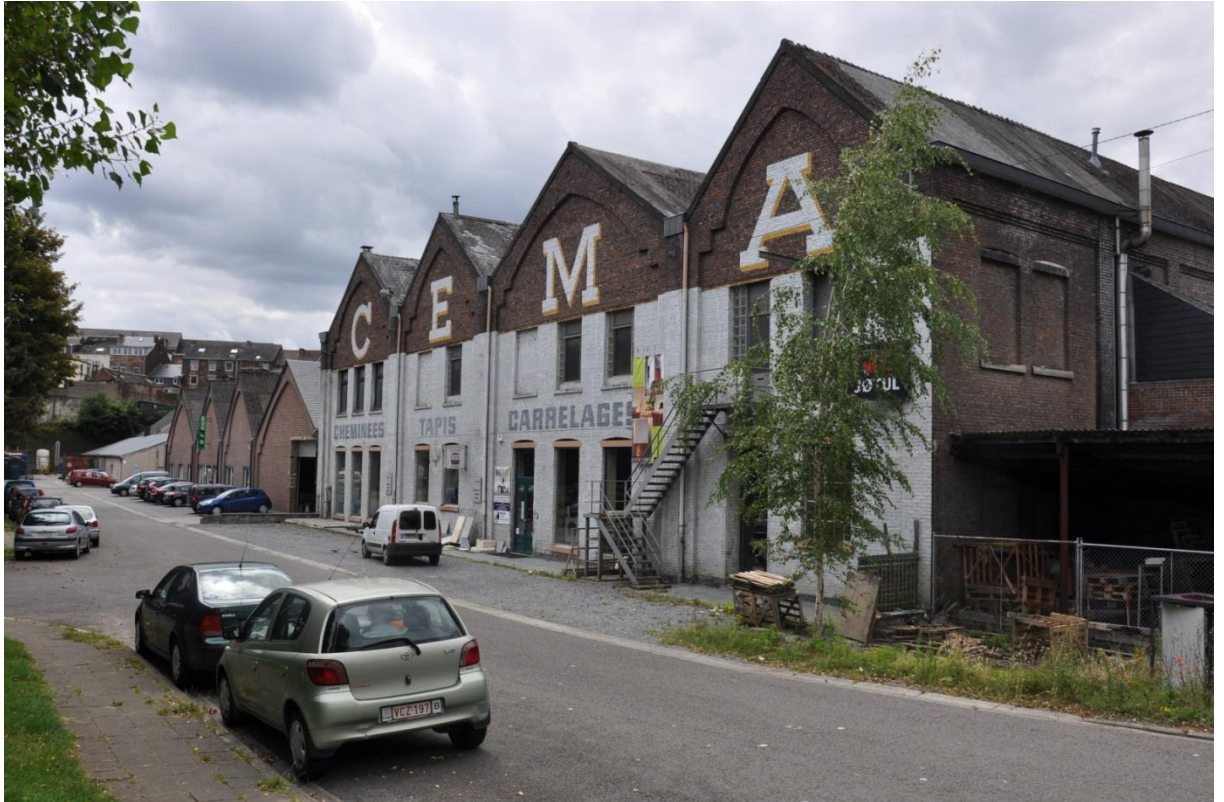
Les quatre halls jointifs, alternativement courts et longs, constituant probablement l'embryon de l'usine. Elévation du côté de la rue de l'Avenir
