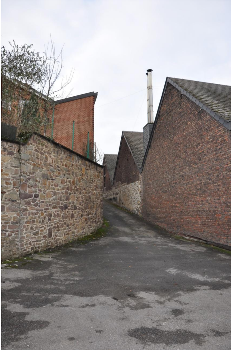
L'élargissement de la ruelle formant placette, à l'arrière des blocs B9-B13
