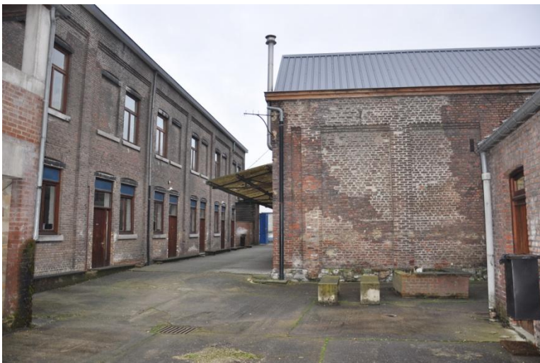
Hall 4 prenant jour sur la courette, modulé toutes les deux travées par des pilastres colossaux
